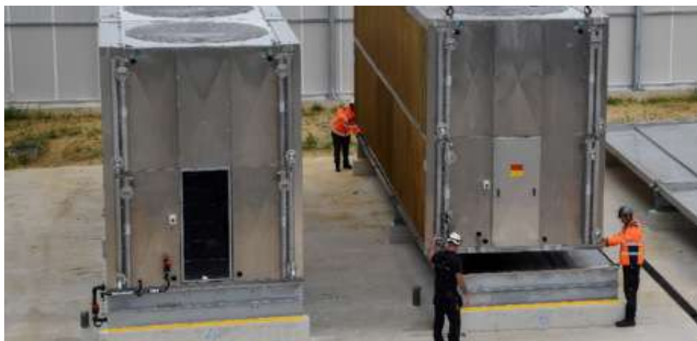
← Mise en place des tours aérorefrigérantes du projet Exascale au TGCC.
